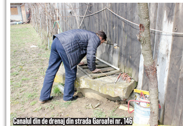
Canalul din de drenaj din strada Găroafei nr. 146
