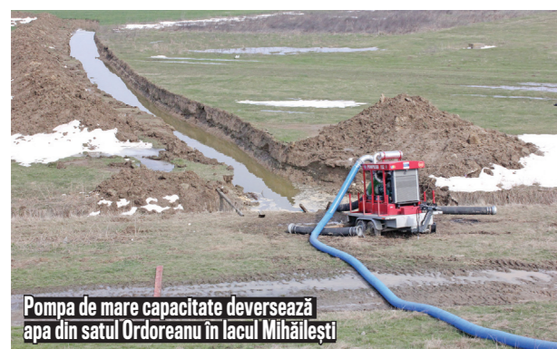
Au fost săpați 6 km de canale pentru evacuarea apei
