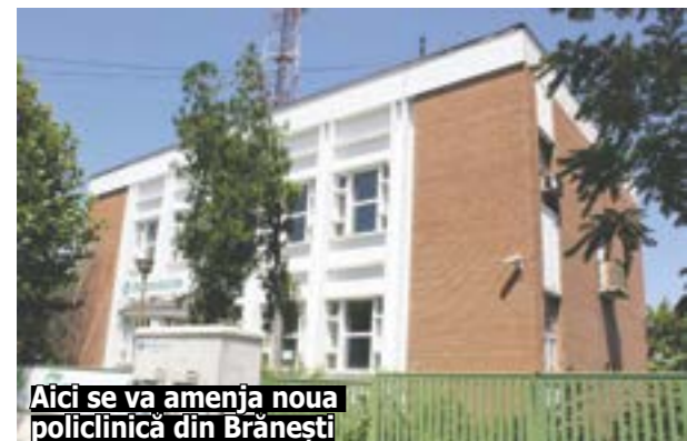
Clădirea dispensarului va fi reabilitată
