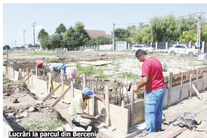
Lucrări la parcul din Berceni
