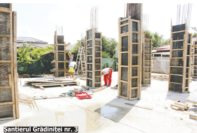
Șantierul Grădiniței nr. 3
