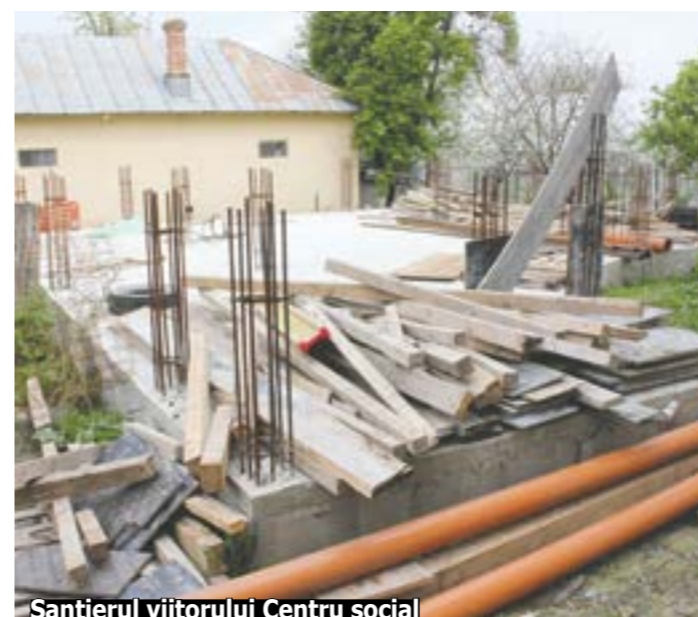
Șantierul viitorului Centru social
