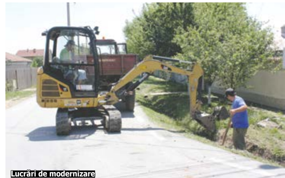
Lucrări de modernizare
